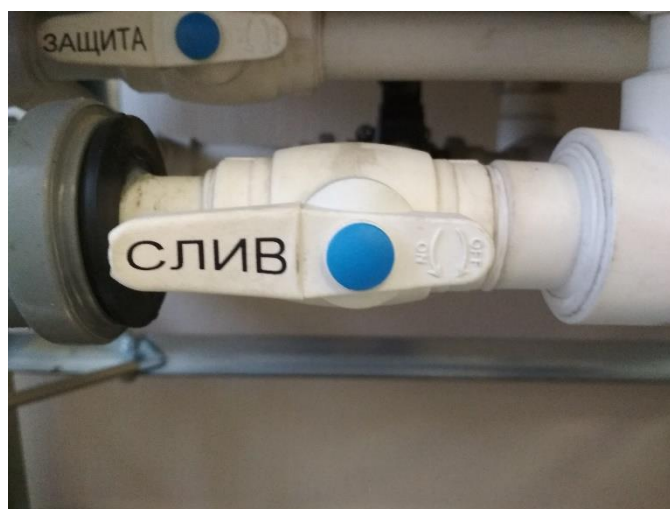
Рис. 2. – Кран слива положение «Открыто»
