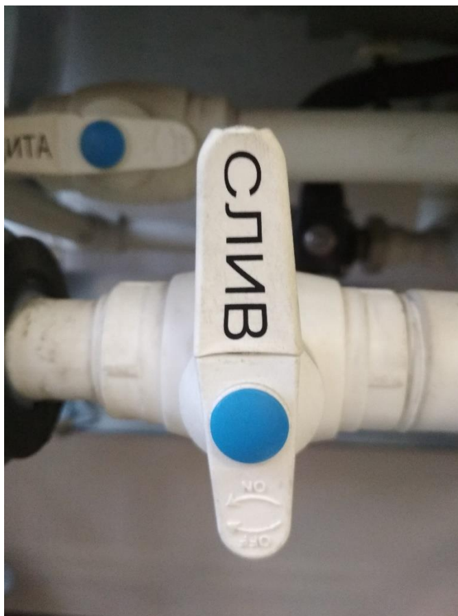
Рис. 4. – Кран слива положение «Закрыто»
