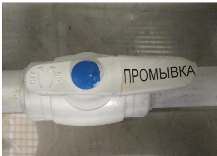
Рис. 5. – Кран промывочных форсунок положение «Открыто». (Кран промывочной форсунки расположен внутри гидрофилтра)
